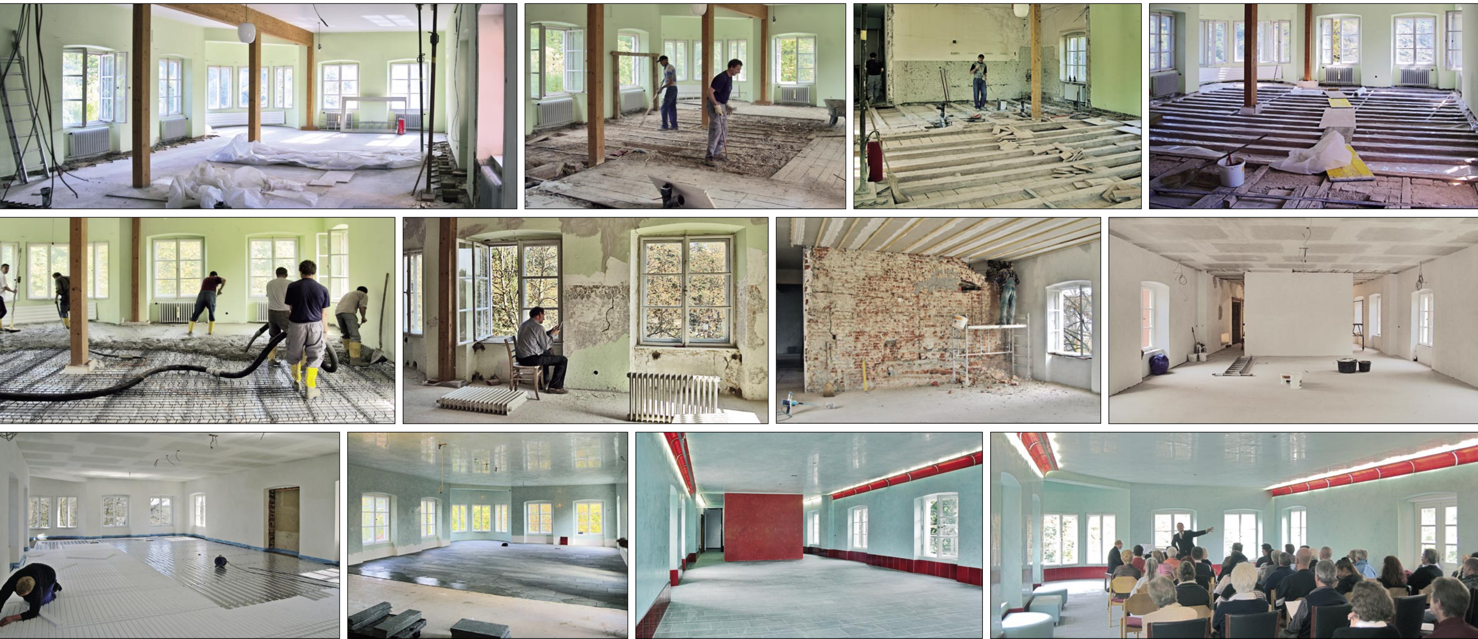
Dokumentation einer Wandlung: Der neue Konzertsaal im ersten Obergeschoss durchlief viele Phasen bis er im Herbst 2008
